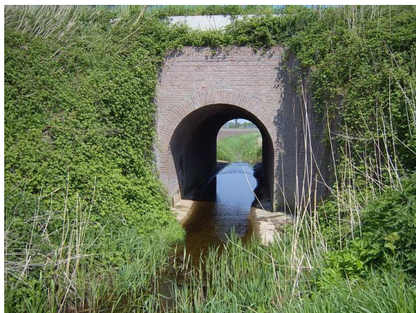
Faunatunnel onder de spoorlijn.
