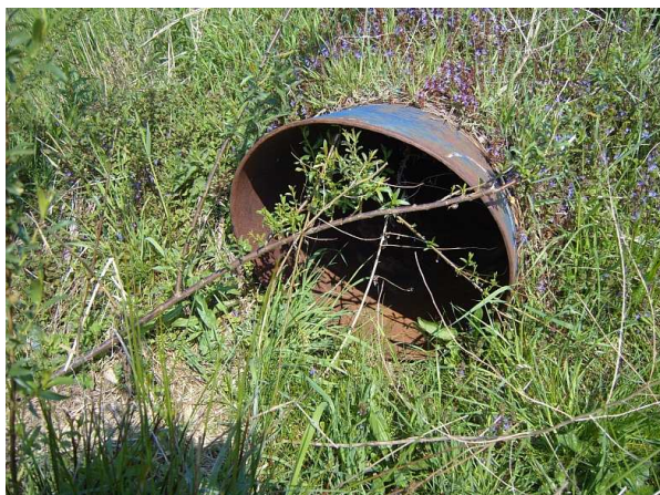
Faunatunnel onder de rijksweg.
