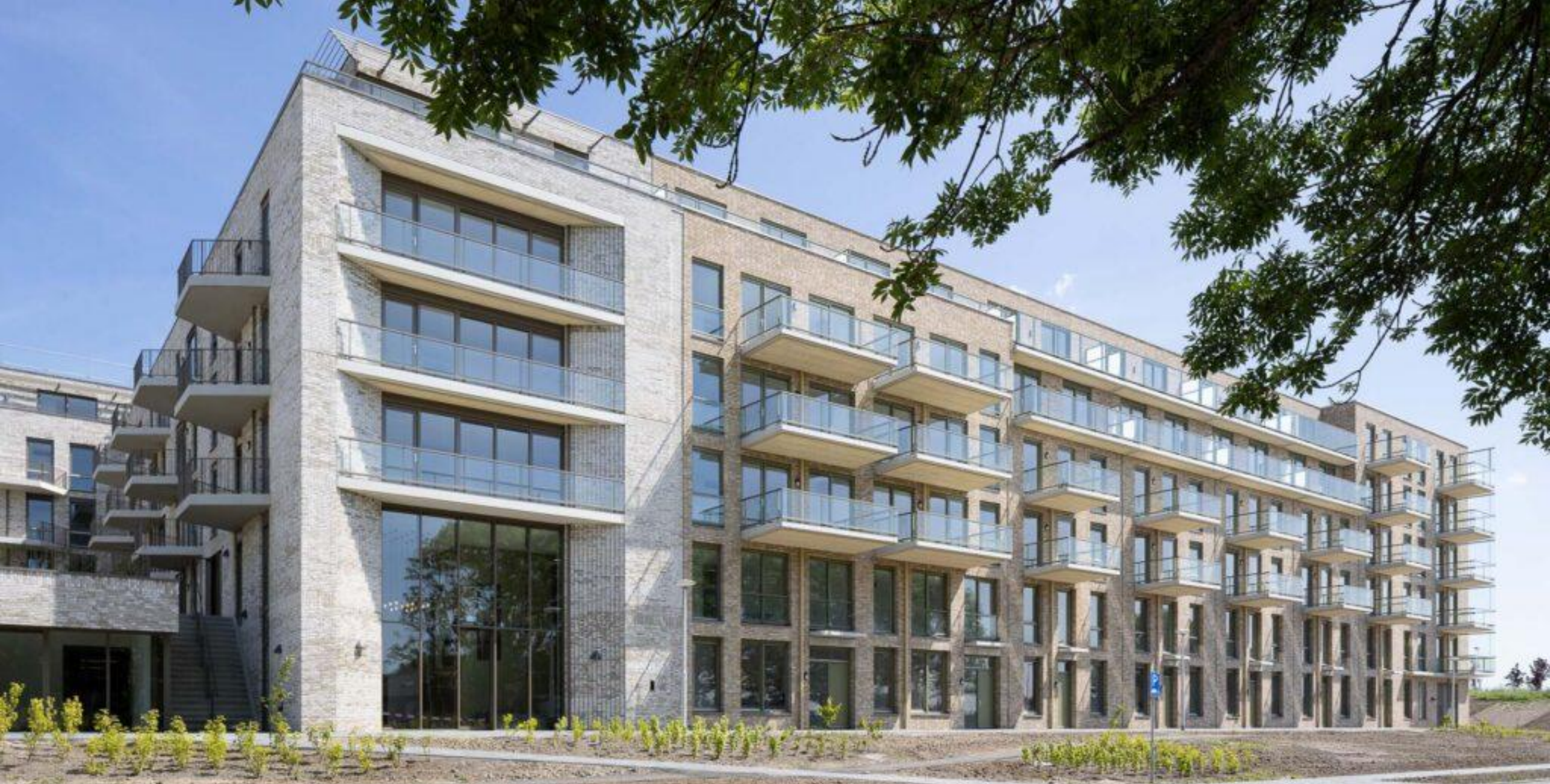
Rijnvliet-Oost - voordeuren aan de straat
