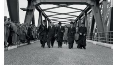
Opening van de verkeersbrug in 1955
