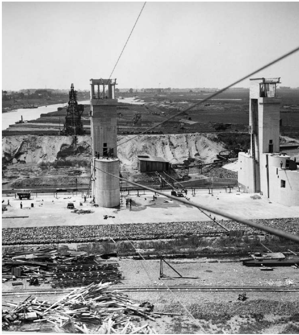
1915 - 1942: bouw van 7 stuwen en sluizen in de Maas om deze bevaarbaar te houden
