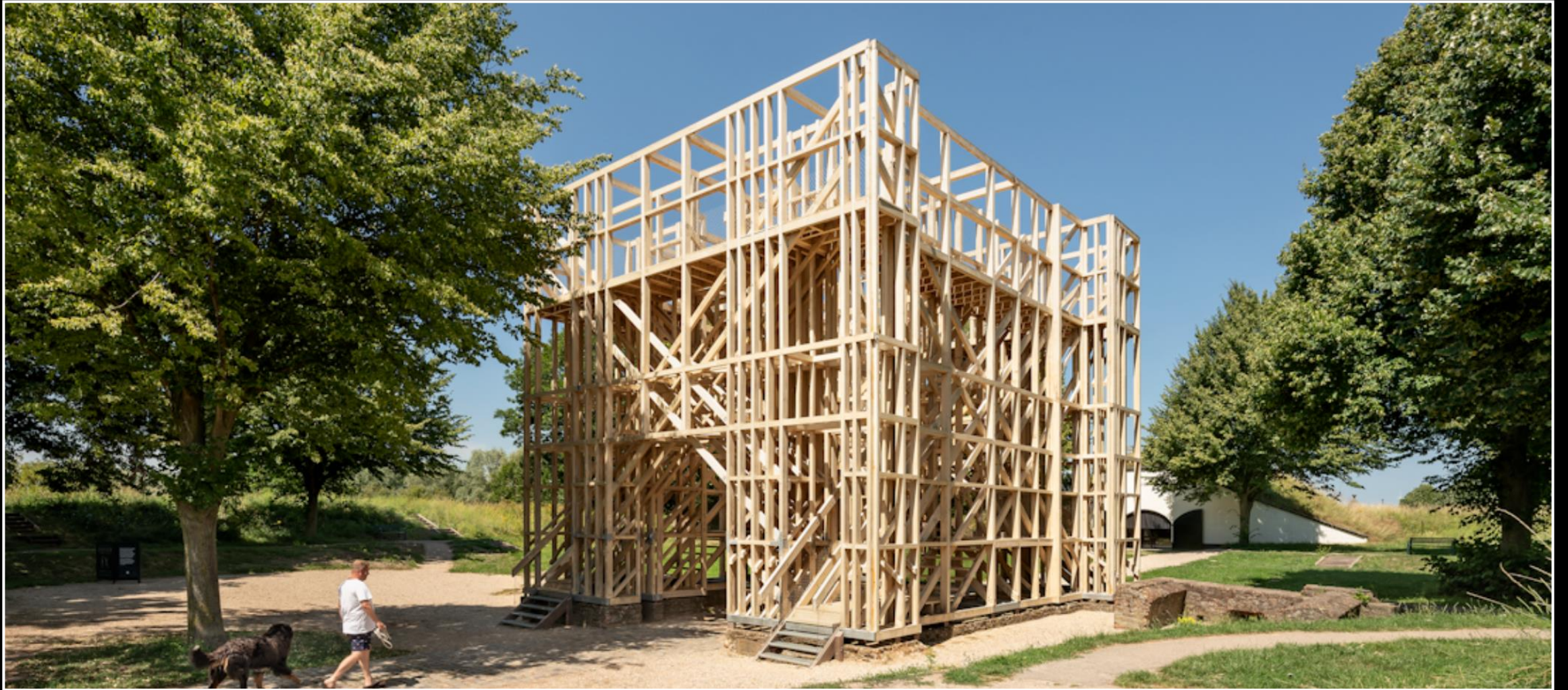
Ro&Ad architecten. 1 april monument, Brielle 2023
