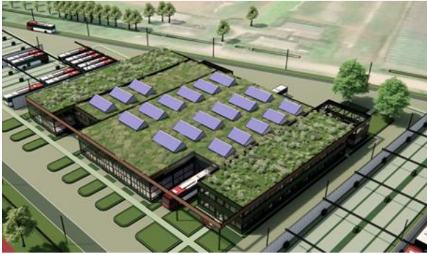
Afbeelding 3: Het dak wordt bedekt door diverse grassen. De zonnepanelen op het dak leveren een deel van de energie voor de installaties in het gebouw (conceptontwerp).
