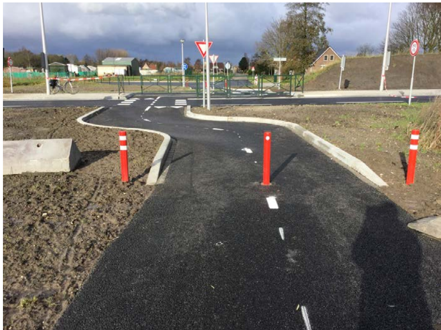
Figuur 12. Chicane bij naderen fietsoversteek om fietsverkeer af te remmen (ook wel afrembocht genoemd). N.B. inleidende ribbelmarkering (lengte 10m) bij paaltje in wegdek ontbreekt; bij voorkeur geen paaltjes, of paaltjes zo ver mogelijk van de discontinuïteit (i.c. bocht) plaatsen (min. 12,5m).
