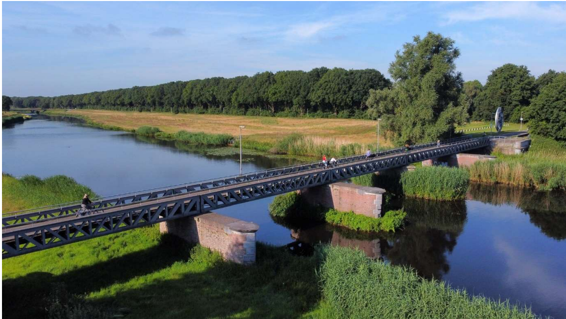
Overzicht van de oude monumentale spoorbrug/Halvezolenpad over het Drongelens kanaal. Foto: Airpro Waalwijk.
